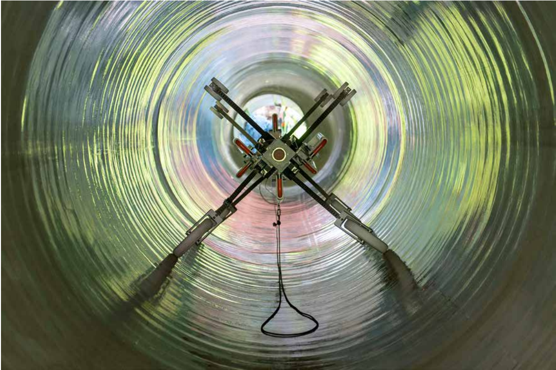
Alphaliner1800, Durchmesser DN 1900, Wanddicke 16 mm, ausgehärtet mit der REE4000 in Höchstgeschwindigkeit von 30-50 cm/min.
