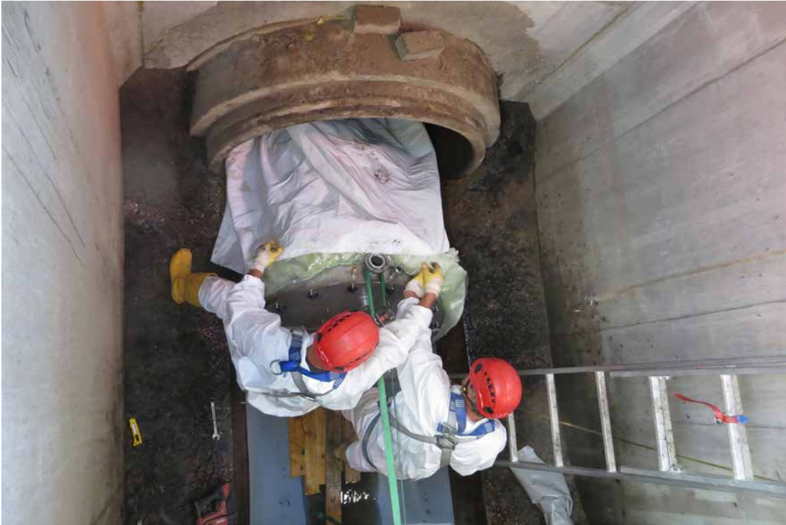
Einbinden eines UV-Liners DN 1500 in den Kanal.
